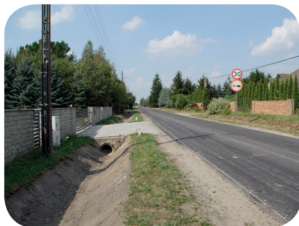
zdj. 2 Przebudowana droga Rasy- Bukowie Górne
