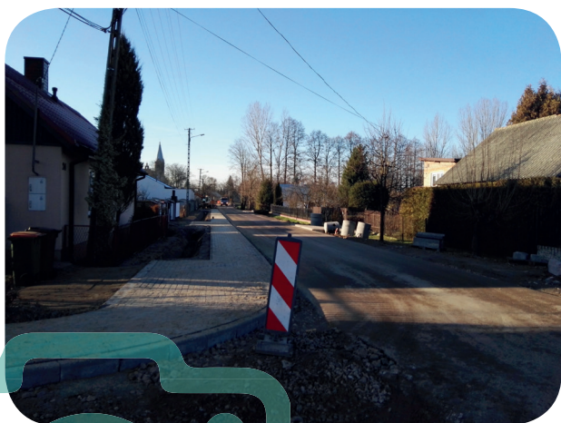
zdj. 1 Droga w Drużbicach w trakcie przebudowy
